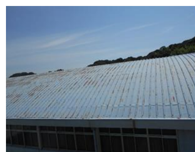
【屋内運動場屋根改修工事】
