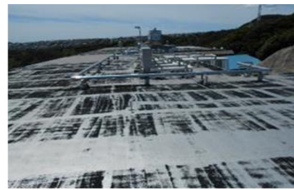
【校舎屋上防水改修工事】
