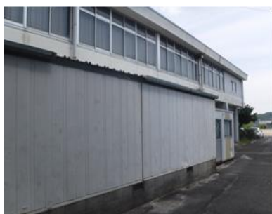
【屋内運動場外壁改修工事】
