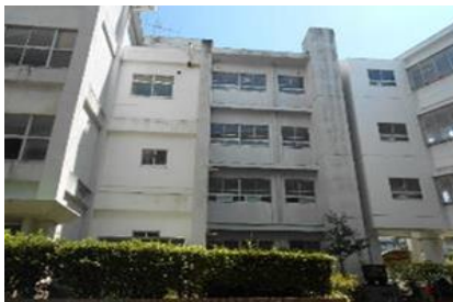
【校舎外壁改修工事】
