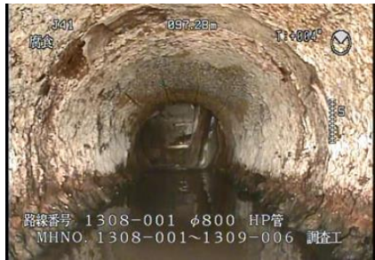
【汚水管更生前】
