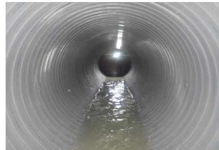
【汚水管更生後】
