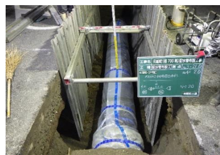
【管路布設完了状況】
