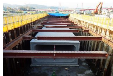
【雨水渠の布設状況】
