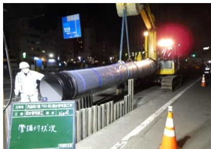
【管路布設状況】
