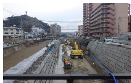
【大井手川(工事中)】
