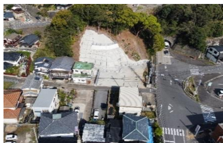
【急傾斜地対策後】
