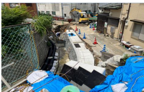
【江川川(工事中)】
