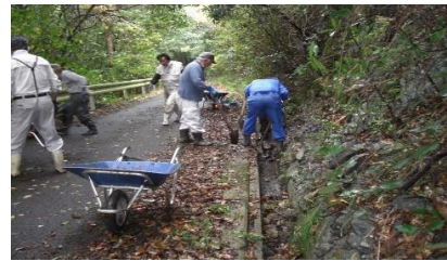
【農業用水路の泥上げ作業】
