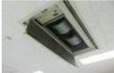
原爆資料館パッケージエアコン等改修工事
