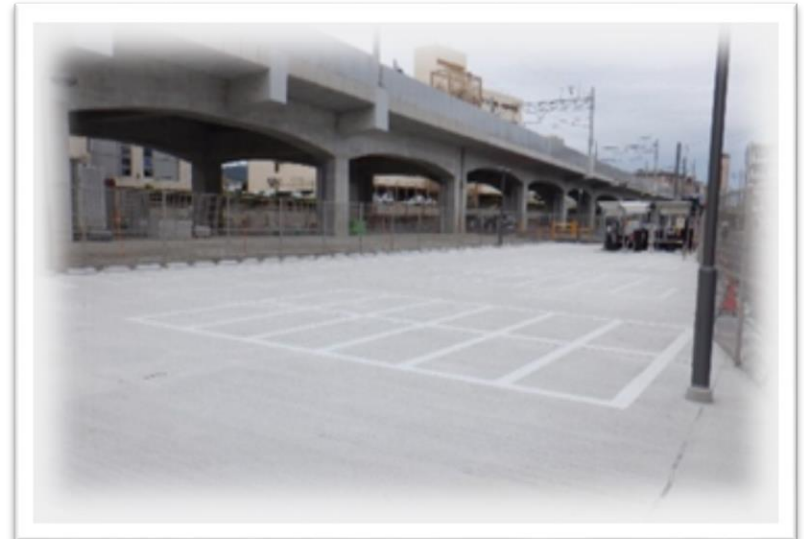
浦上駅二輪車等駐車場
