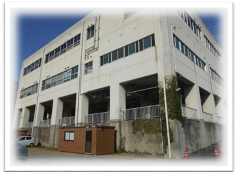
動物愛護管理センター 築39年
