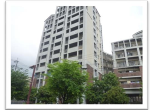
若葉住宅 築30年／1棟／58戸
