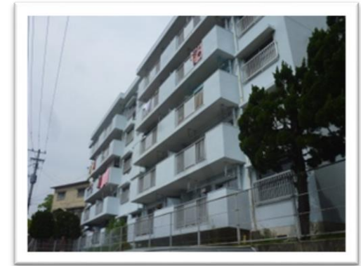
銭座住宅 築43年／2棟／32戸
