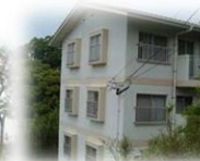
瀬戸屋敷住宅
