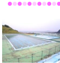
野母崎総合運動公園水泳プール
