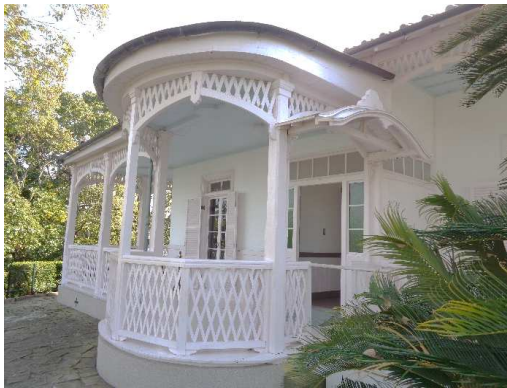
旧ウォーカー住宅(H30年度耐震工事完了)
