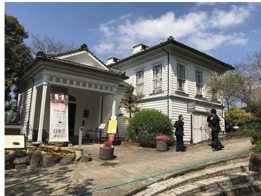
旧自由亭(R4年度耐震工事予定)
