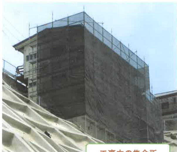
工事中の集会所
