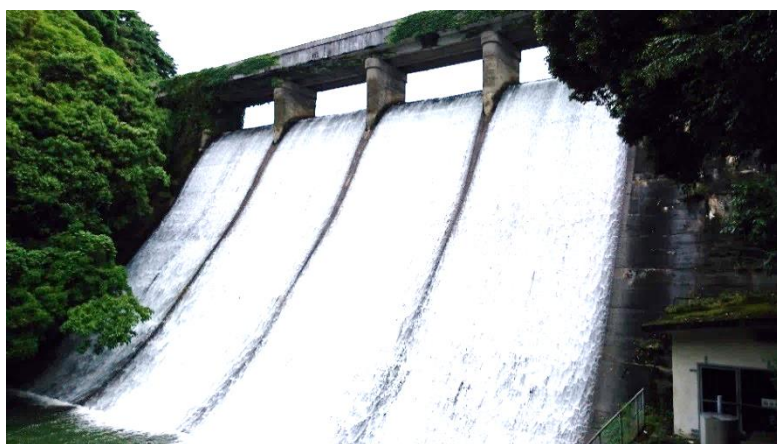
浦上ダム堰堤
