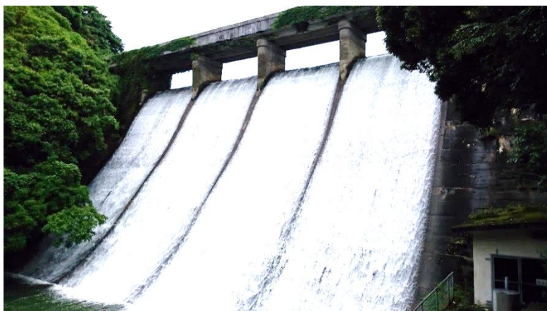
浦上ダム堰堤
