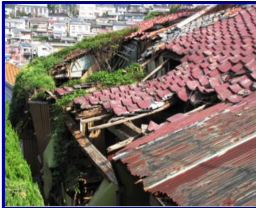
建物全体が崩落、または、屋根の一部が崩壊するなど、構造的に家屋としての効用を果たしていない状態
