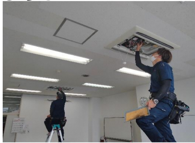
第2研修室空調修理
