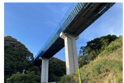
（鹿尾ダム付近では、長崎南環状線の整備が進んでいます。）
