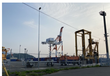
(貨物用のクレーンも設置されています)
