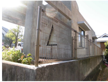
👉 取り替えられたフェンス
