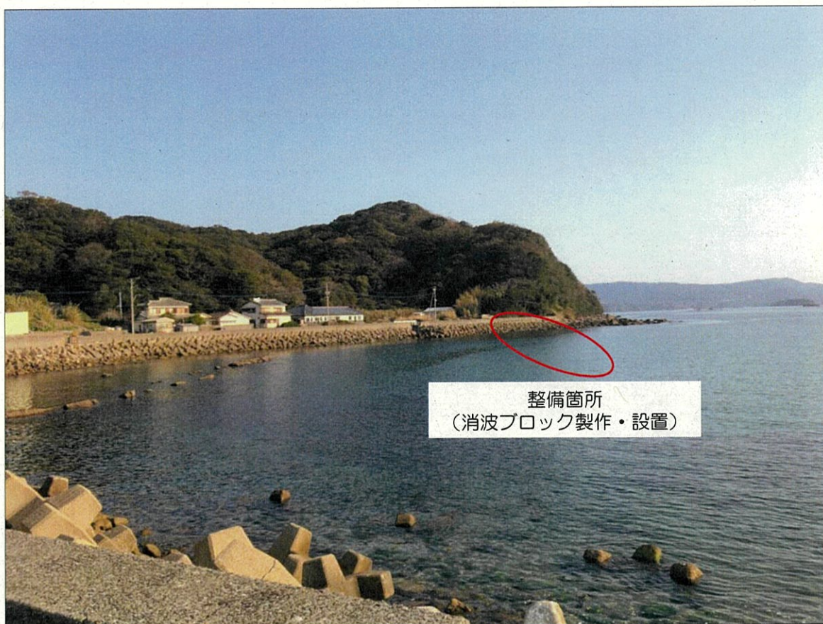
整備箇所全景
