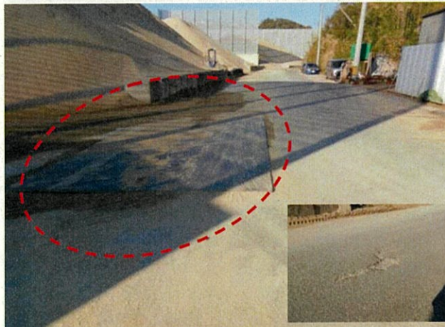
道路改良：舗装補修
