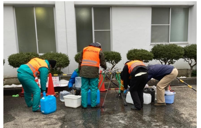
仮設給水栓による給水(2/1~)
