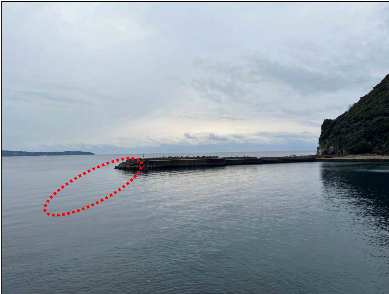
防波堤改良箇所現況
