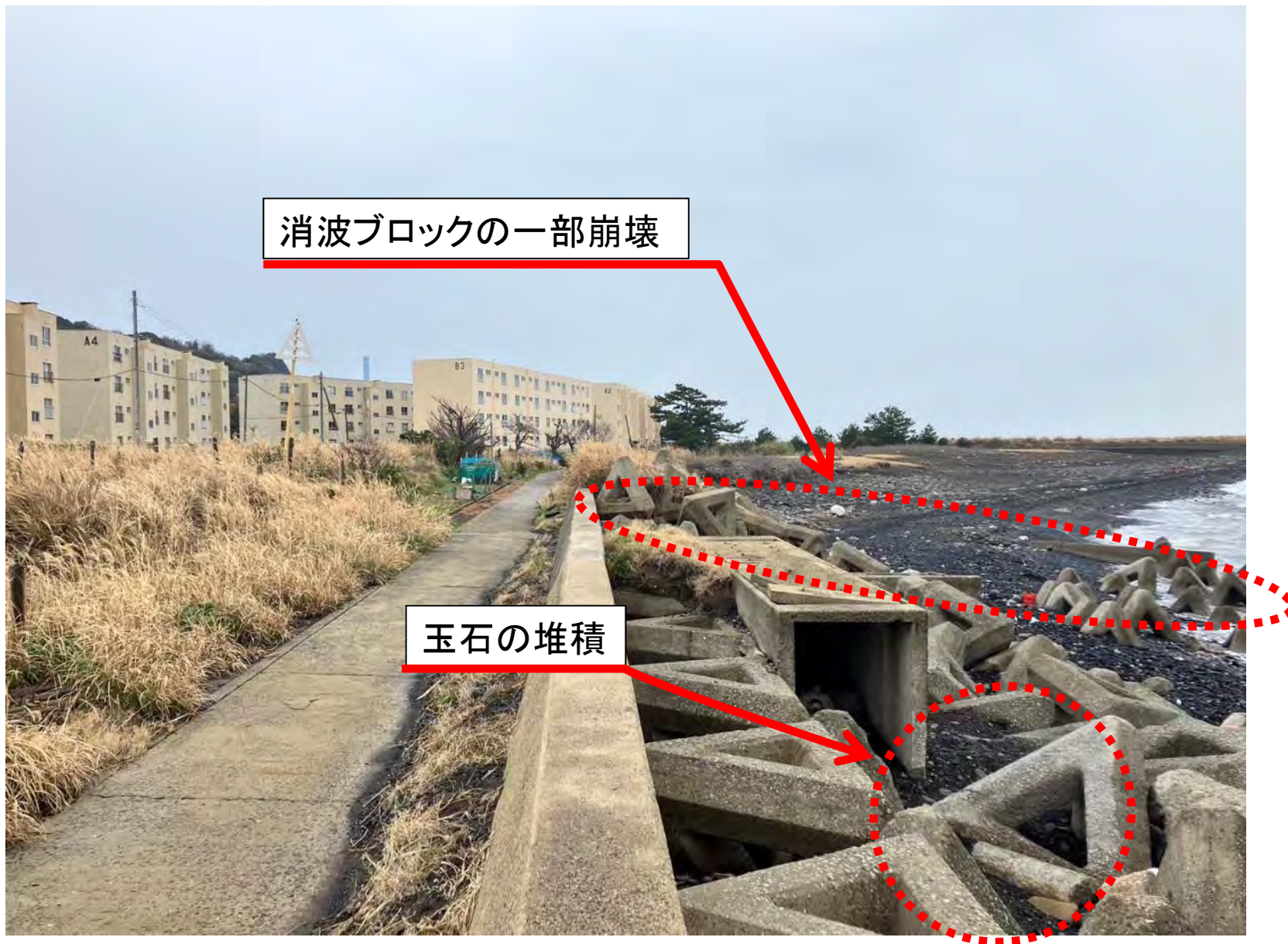
護岸改良箇所の現況
