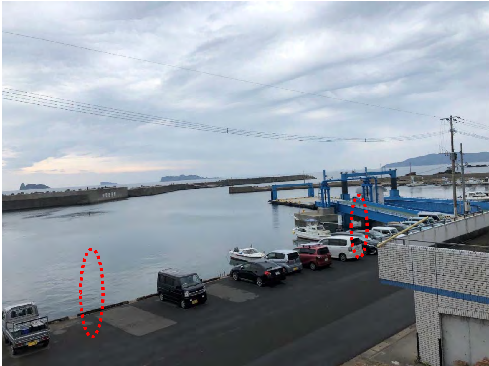
物揚場改良箇所 の 現況
