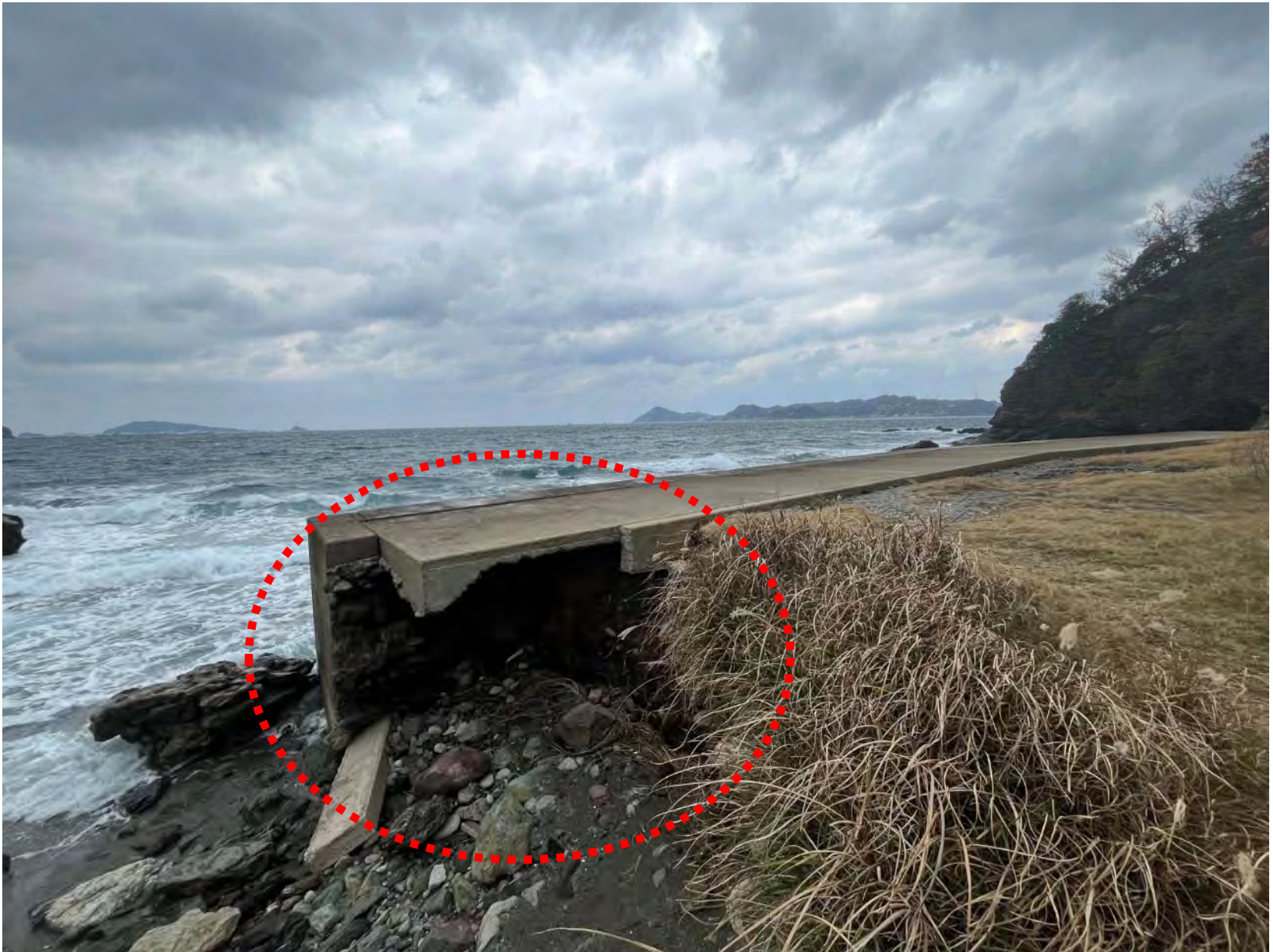
護岸改良箇所の現況
