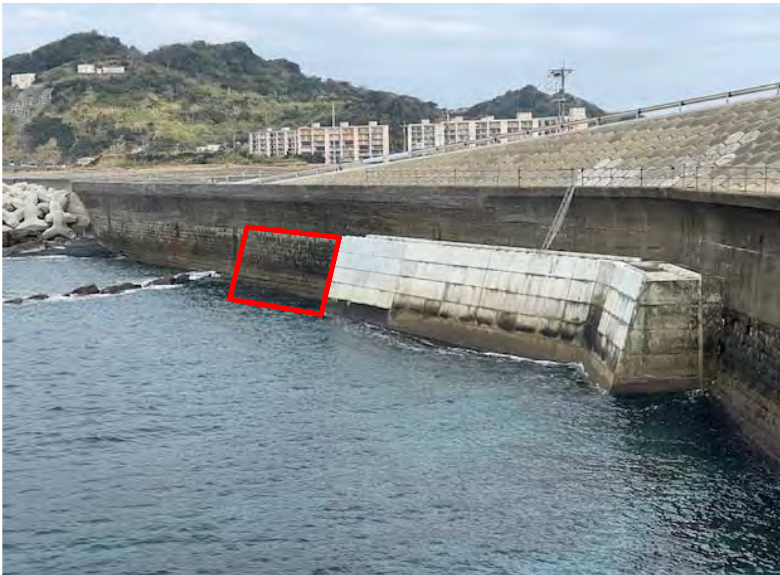
護岸改良箇所の現況
