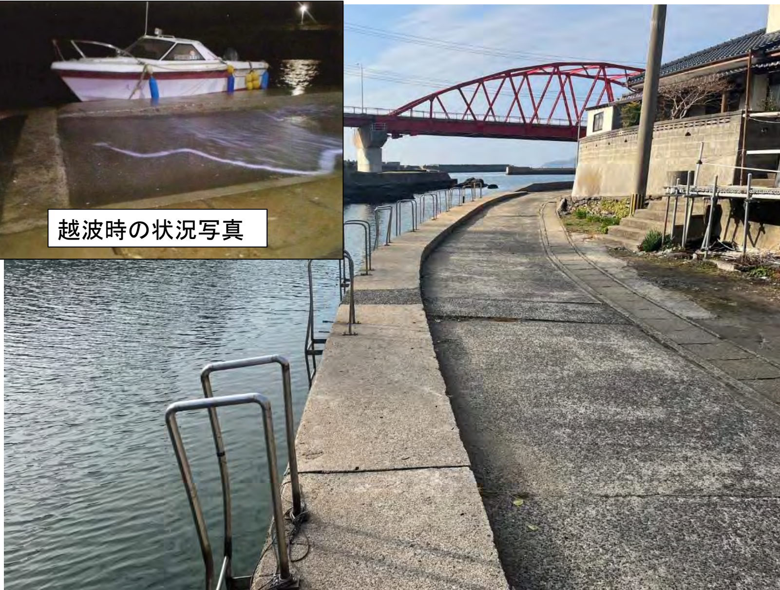
護岸改良箇所の現況
