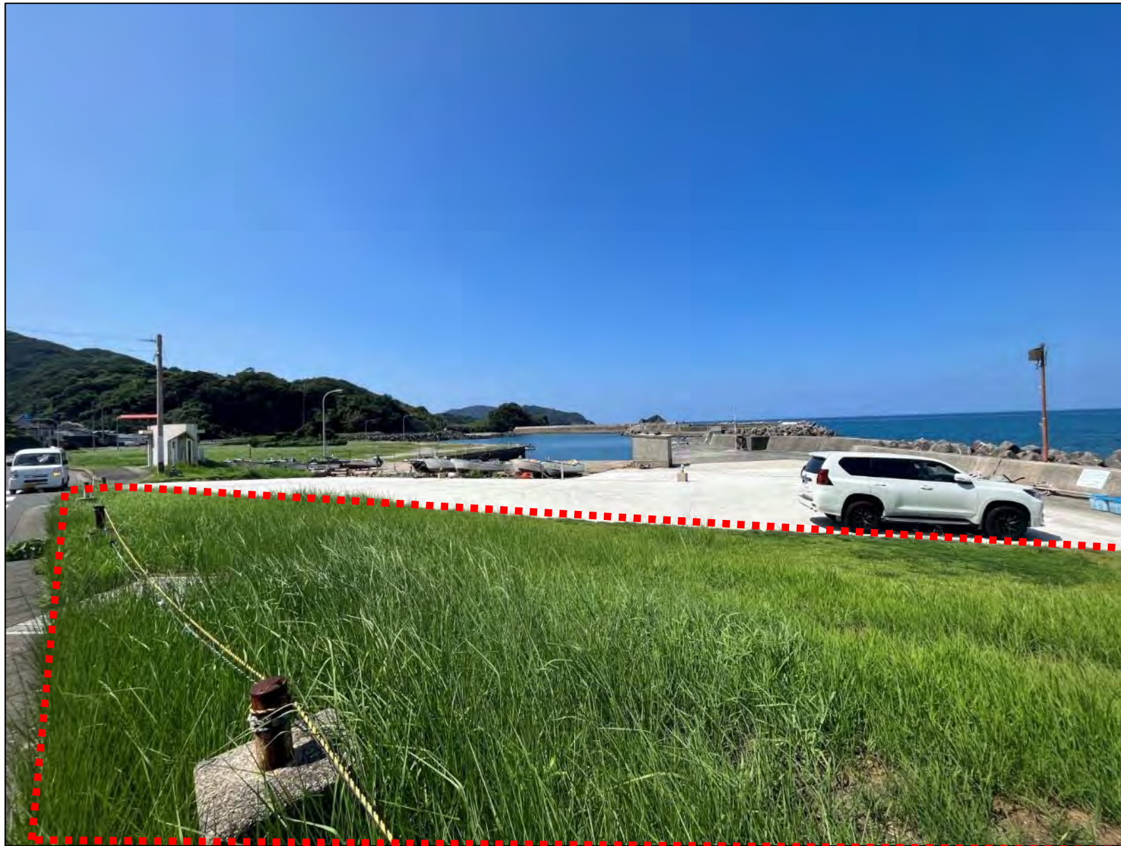
船揚場改良箇所の現況
