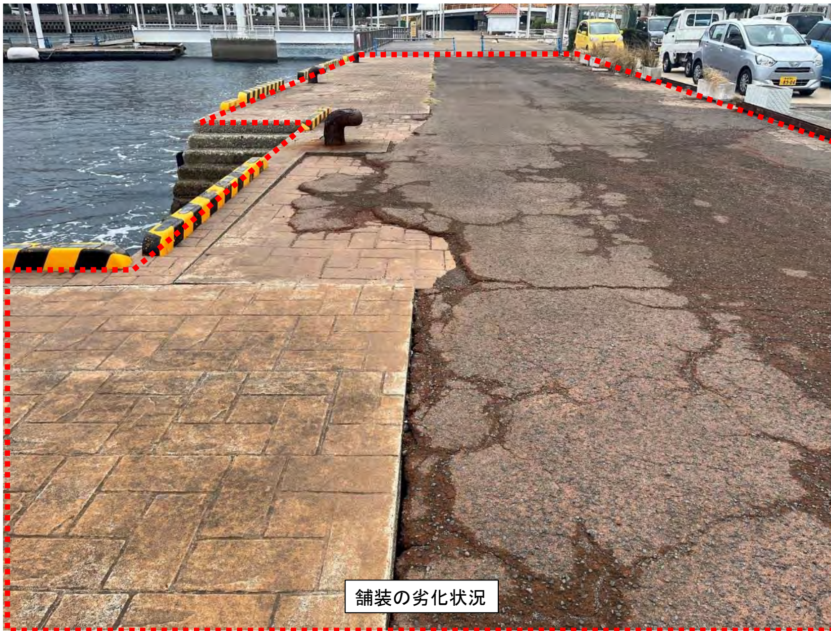
物揚場改良箇所の現況
