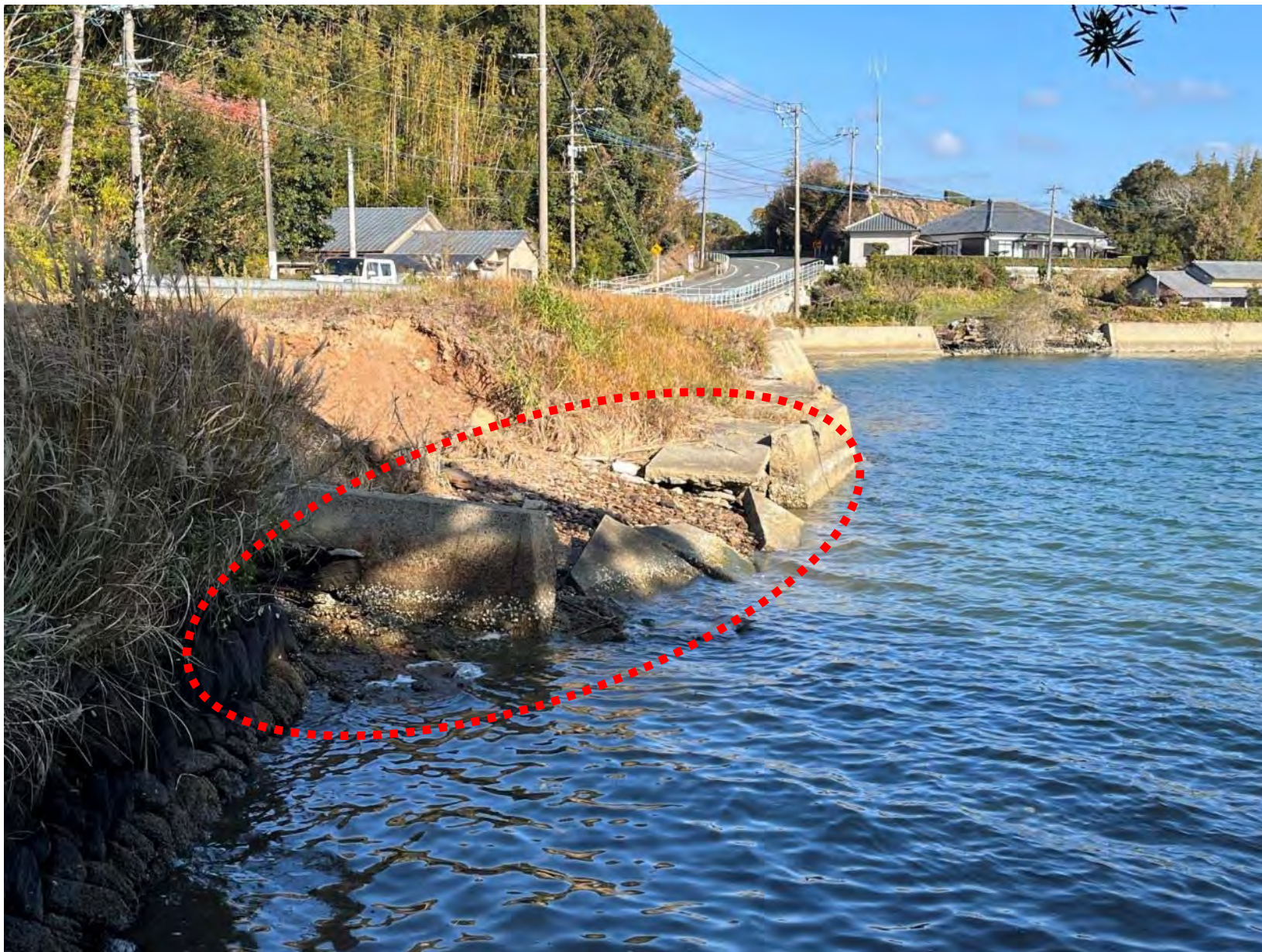
護岸改良箇所の現況
