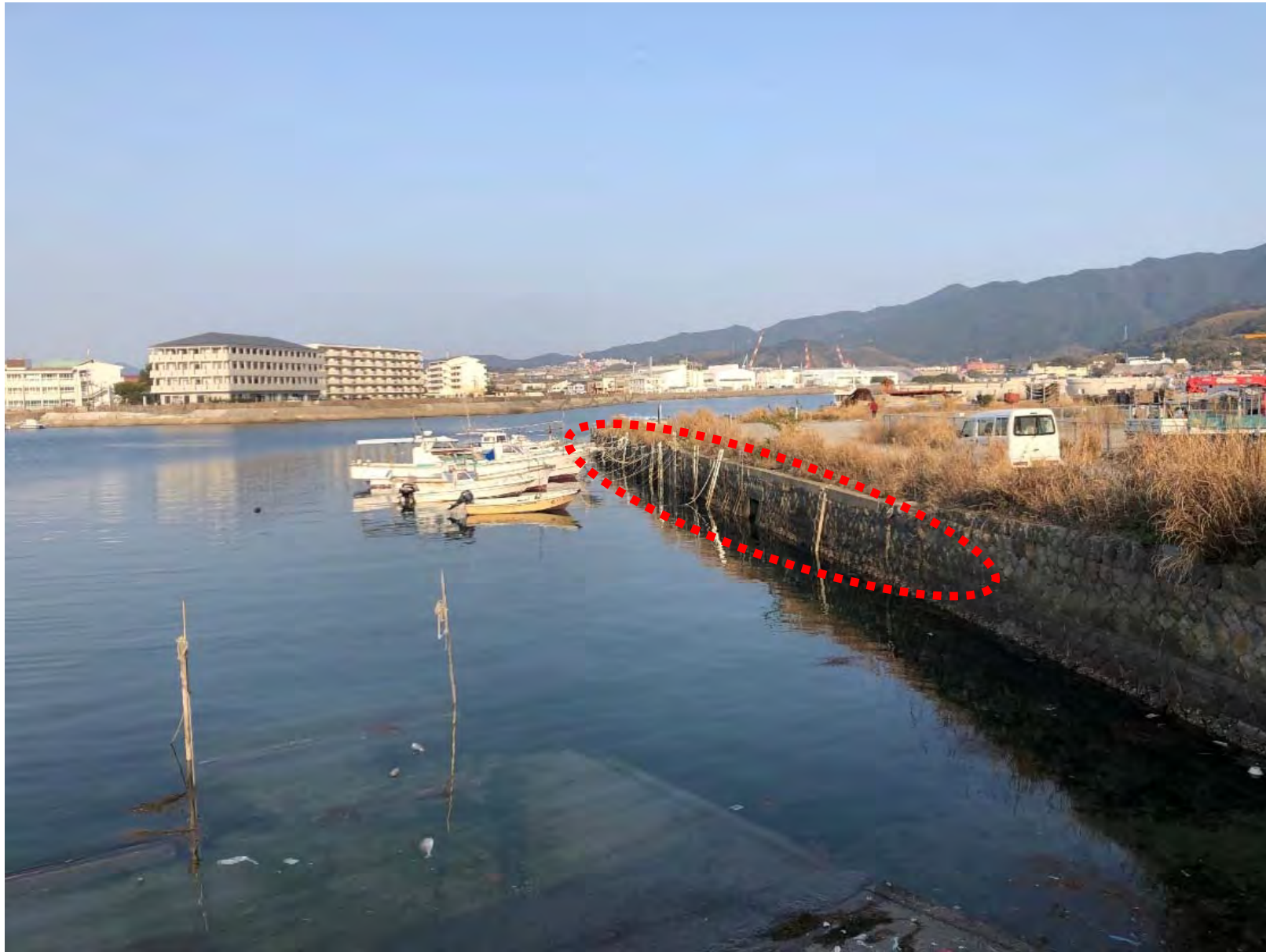
護岸改良箇所の現況
