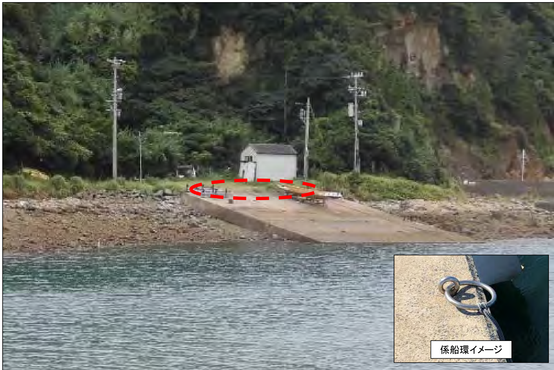
船揚場改良箇所の現況
