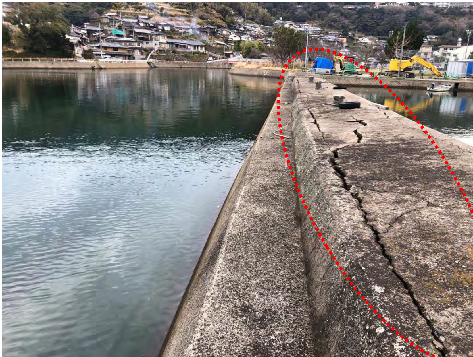
防波堤改良箇所 の 現況
