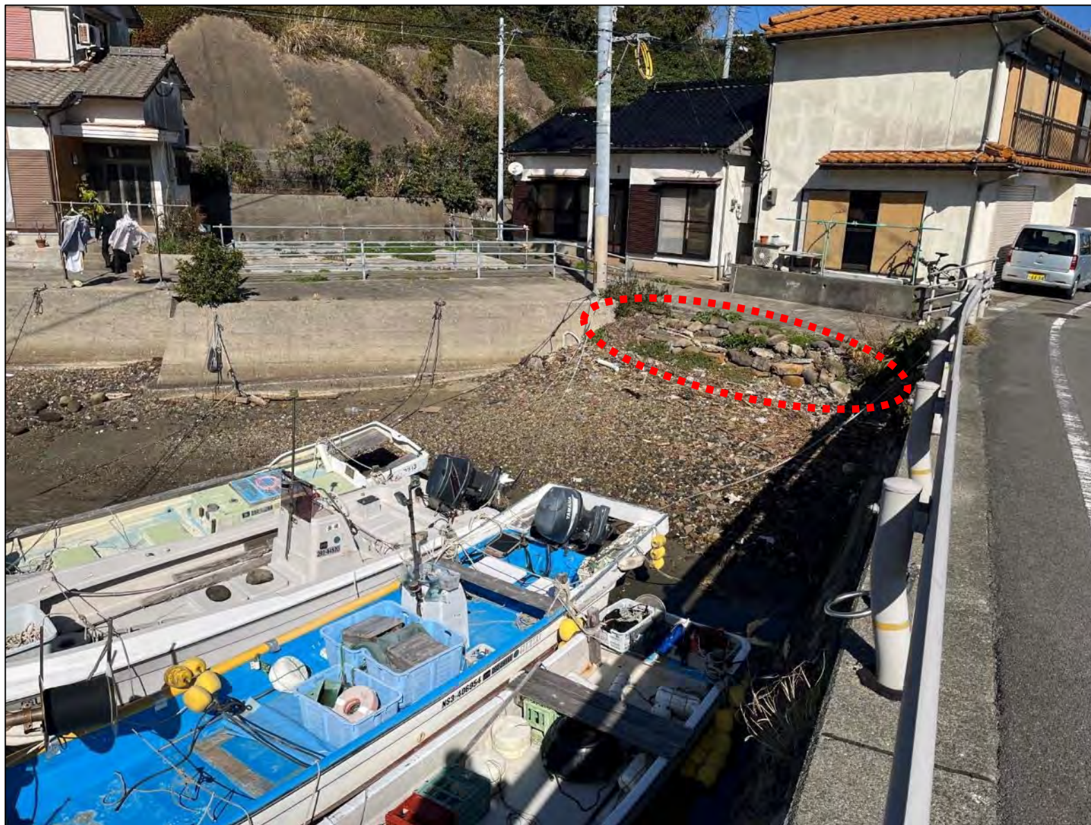
護岸改良箇所(石積み)の現況
