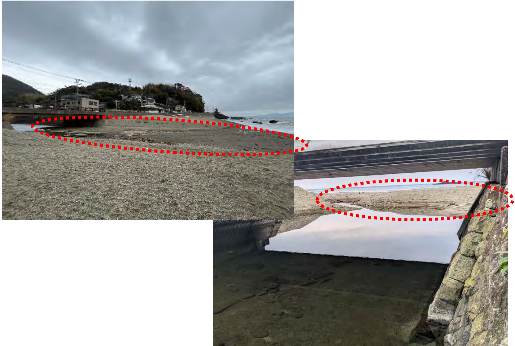
泊地浚渫箇所 の 現況
