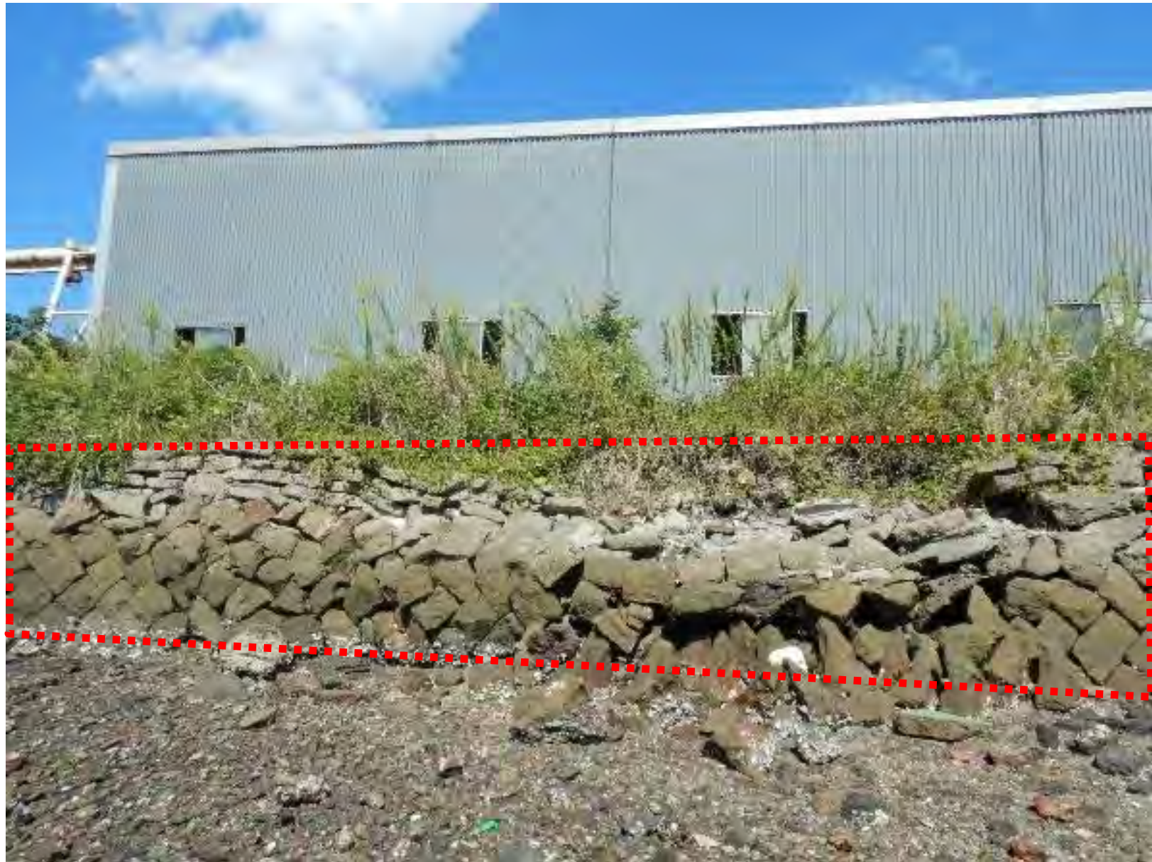
護岸改良箇所の現況
