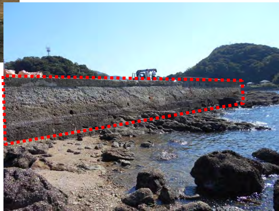
護岸改良箇所の現況
