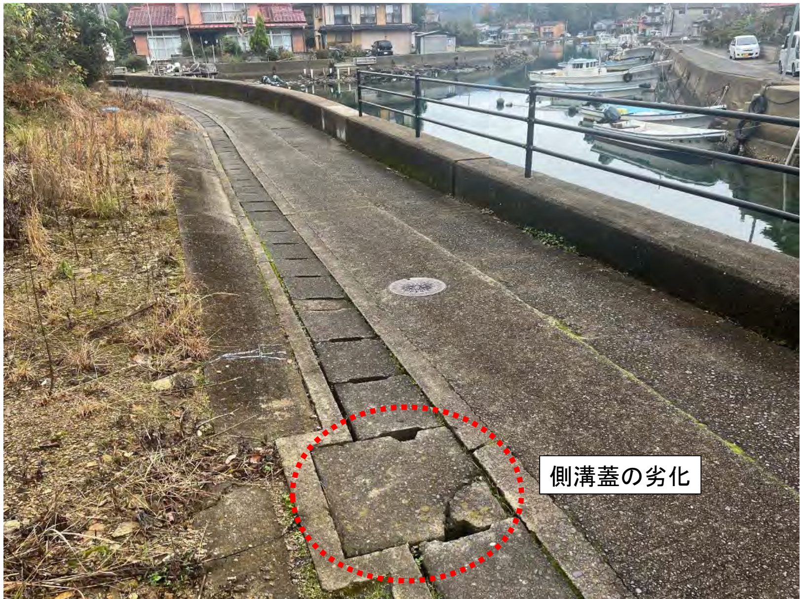
護岸改良箇所 の 現況
