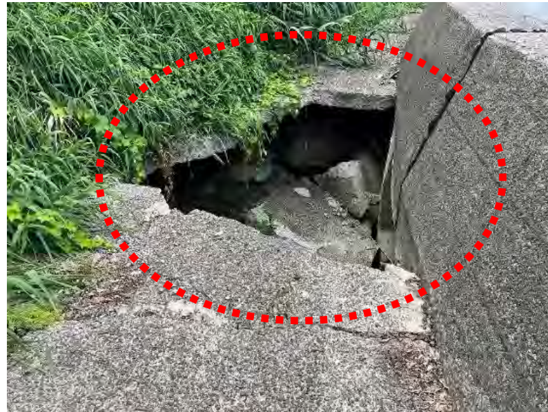
護岸改良箇所の現況
