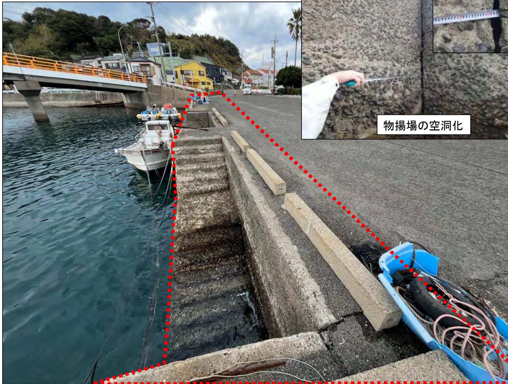
物揚場改良箇所 の 現況
