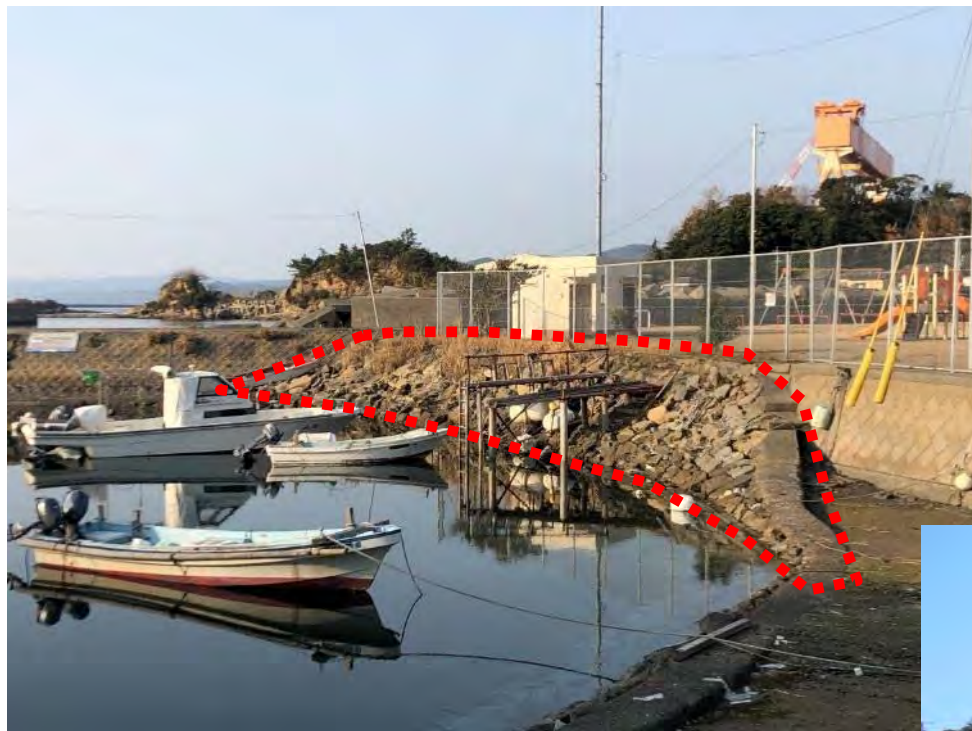
護岸改良箇所の現況
