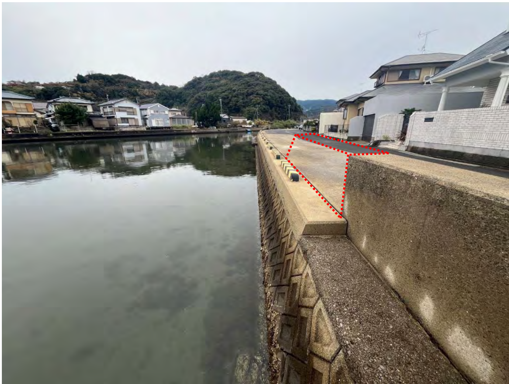
護岸改良箇所の現況
