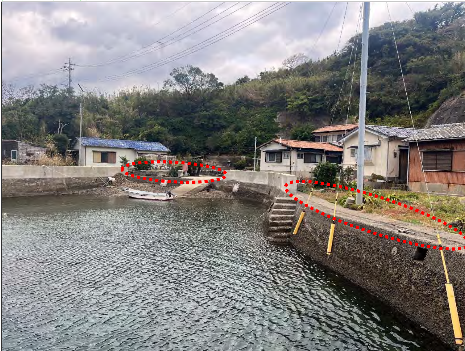
護岸改良箇所の現況(護岸の嵩上げ)
