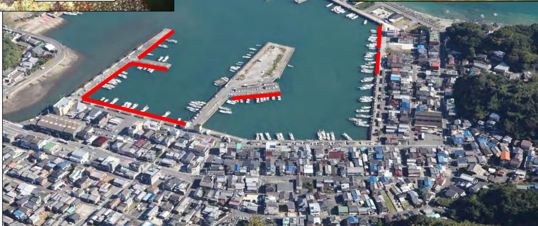
物揚場改良箇所の現況
