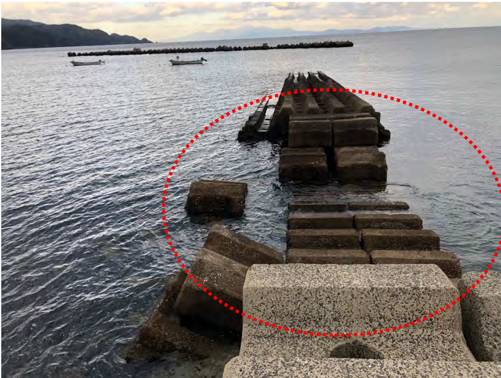
突堤改良箇所の現況
