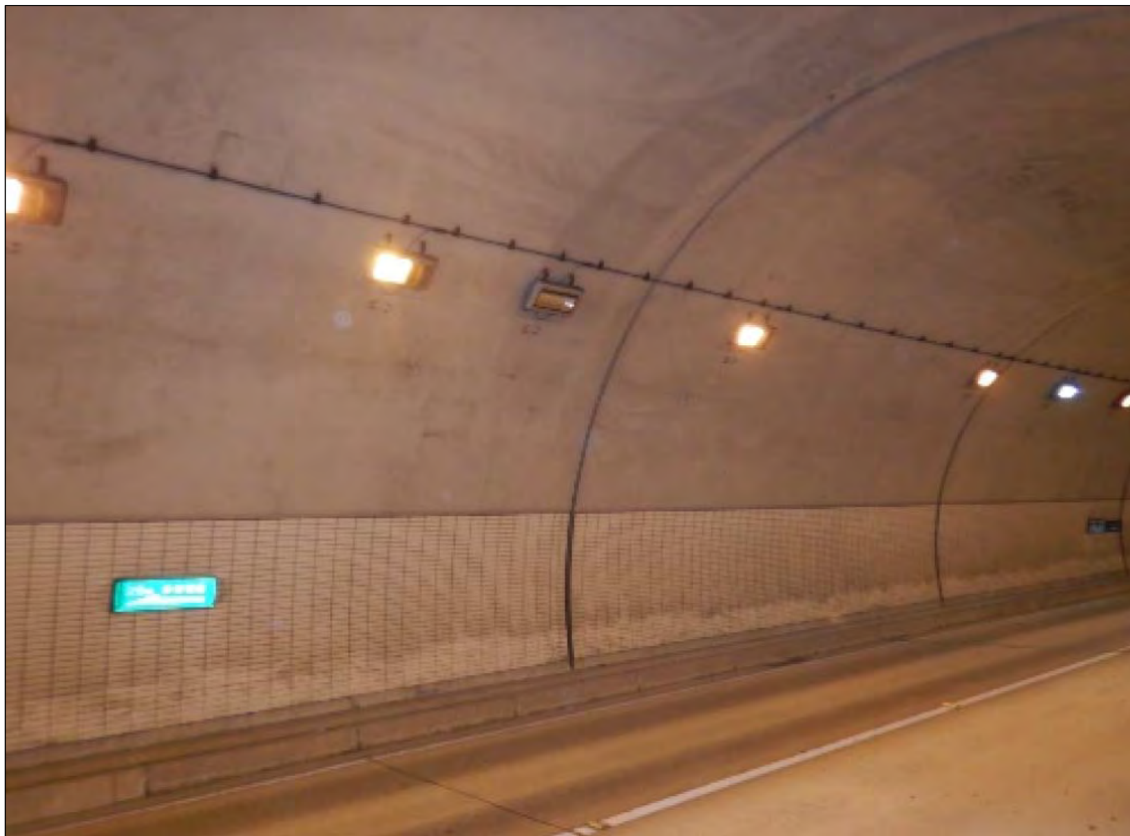
道路改良箇所（照明灯のLED化）
