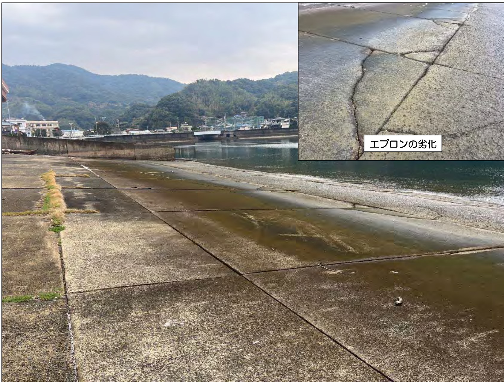
船揚場改良箇所 の 現況
