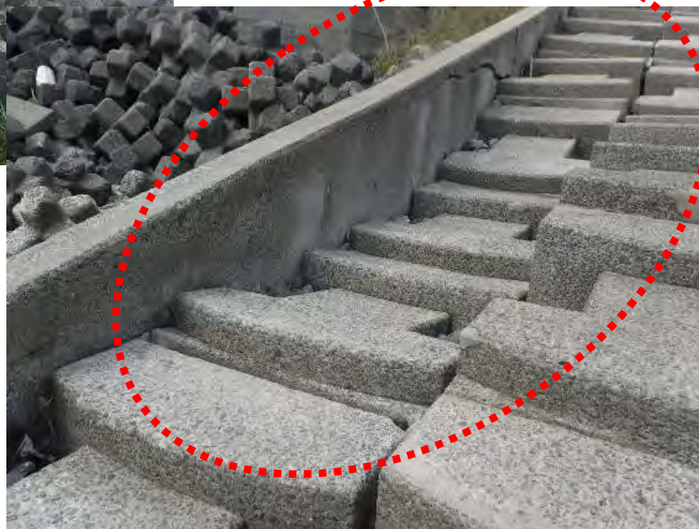
護岸改良箇所の現況
