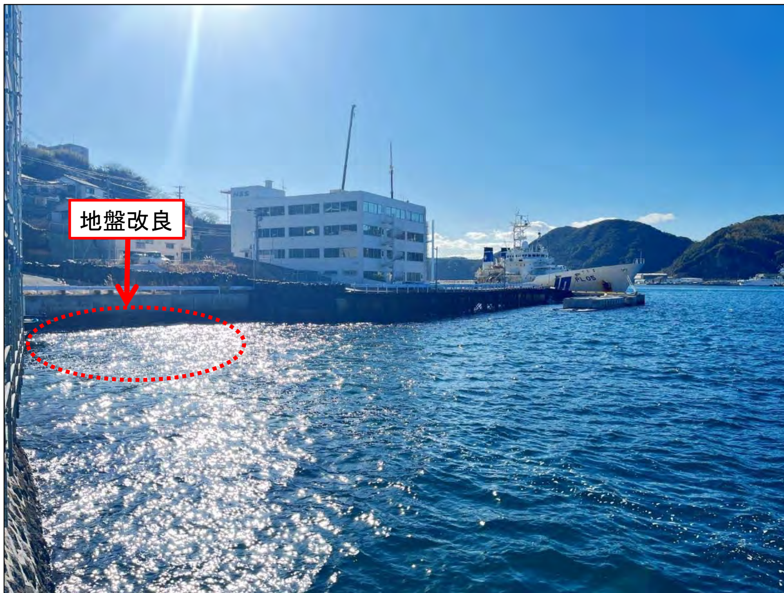
岸壁改良箇所現況
