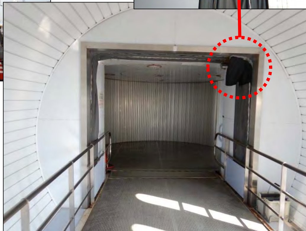
ターミナル改良箇所の現況
