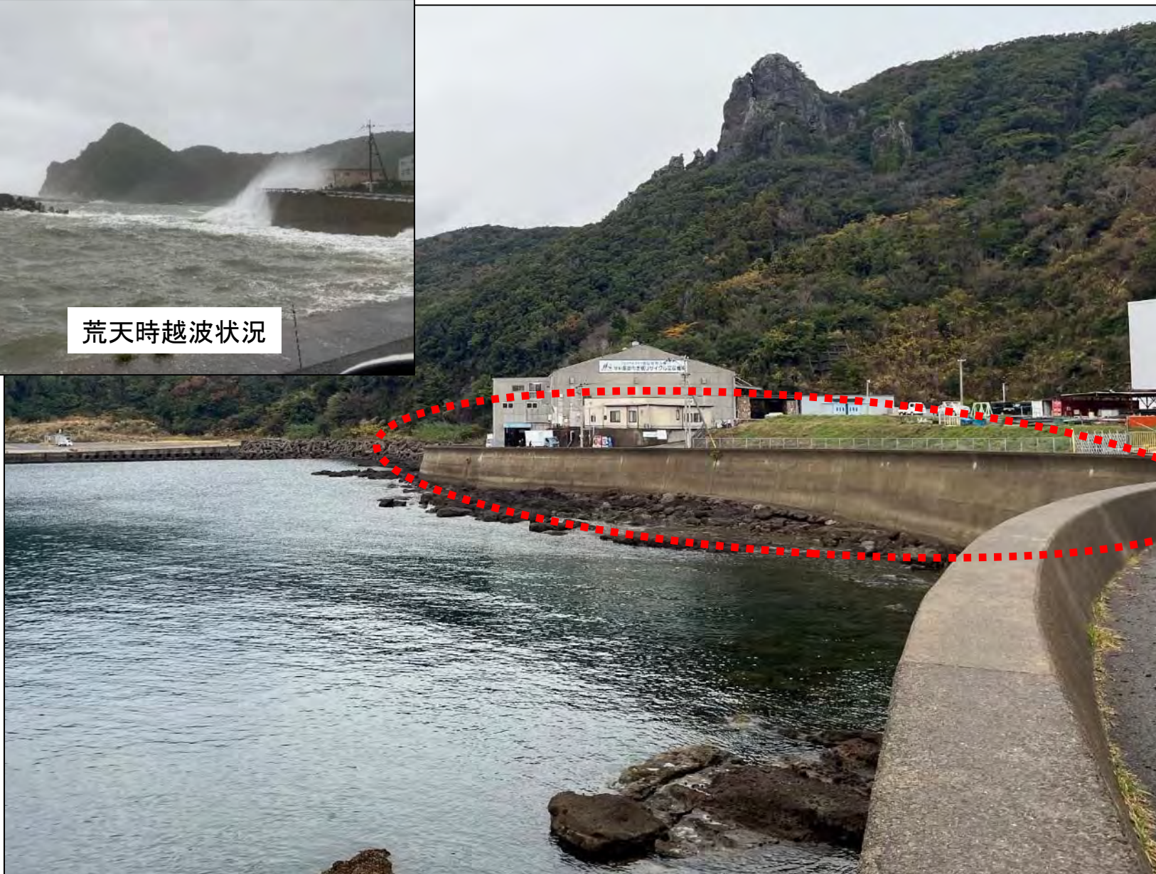
護岸改良箇所現況
