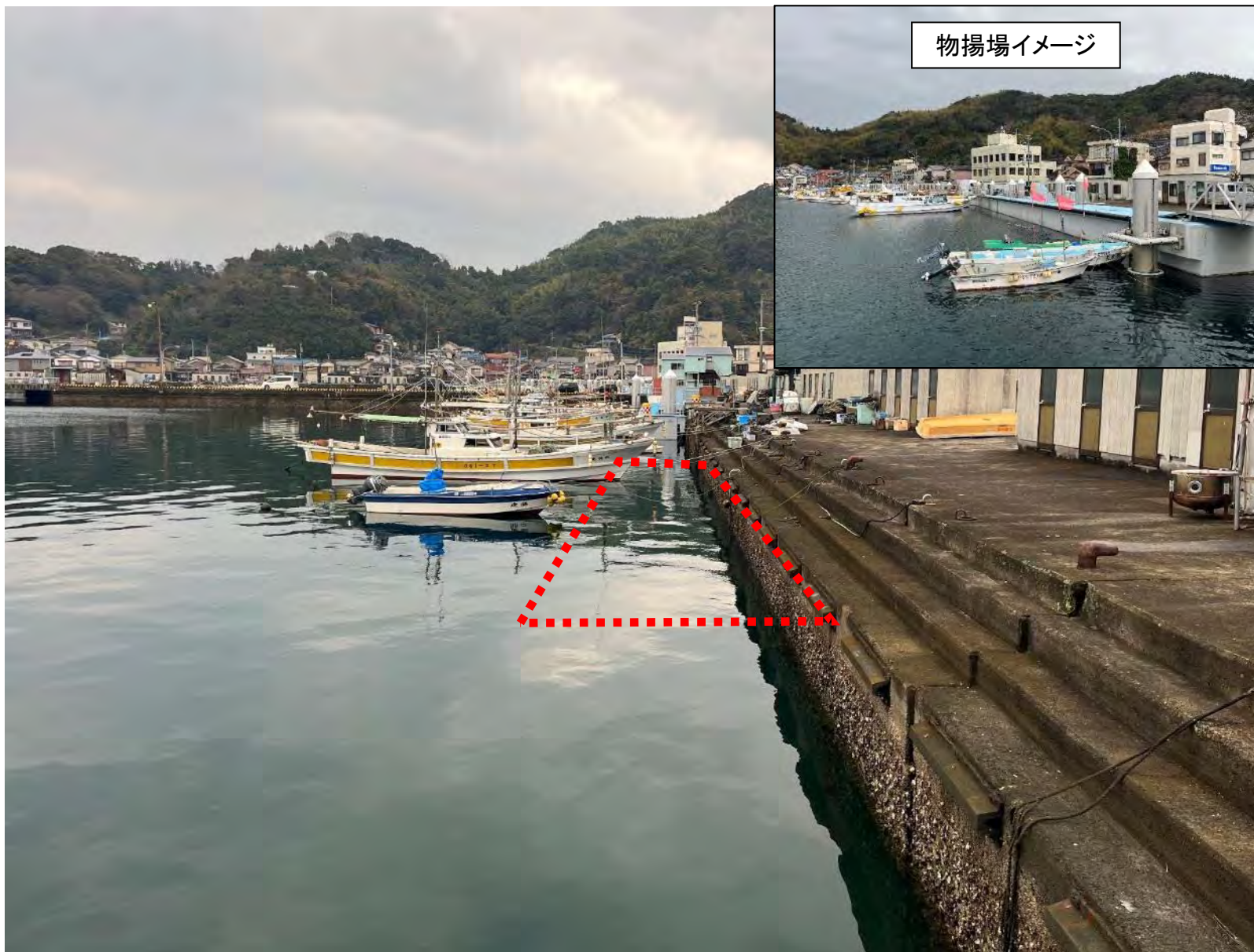
物揚場改良箇所の現況
