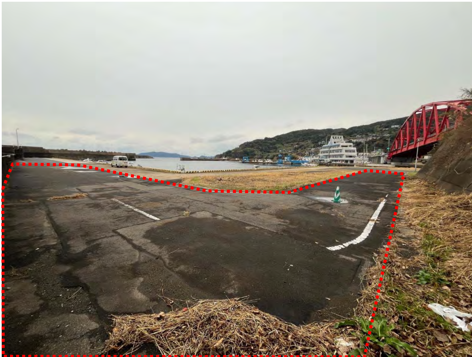
道路改良箇所の現況
