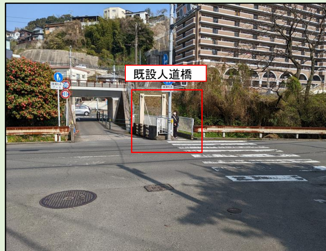
現況写真(A)
