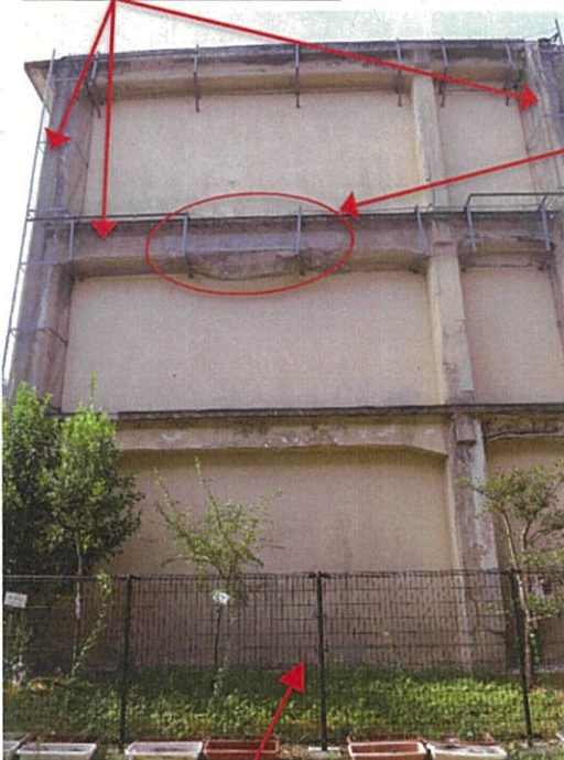
既存進入防止フェンス
