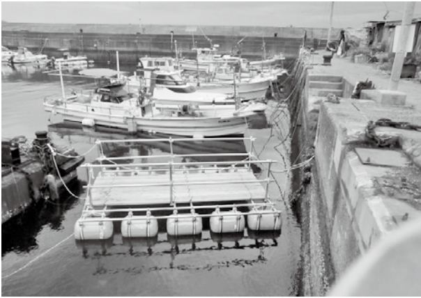
▲県設置の仮設連絡橋
