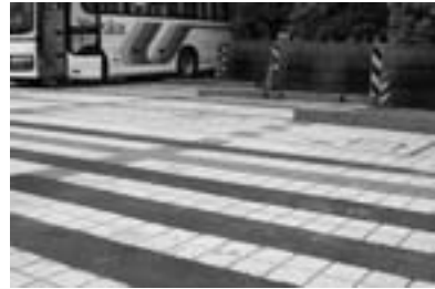
原爆資料館及び追悼平和祈念館のバス駐車場(補修工事後)
